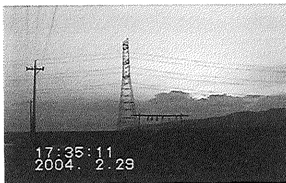
図 7. 日没時。送電線より200m離れた地点で撮影。
